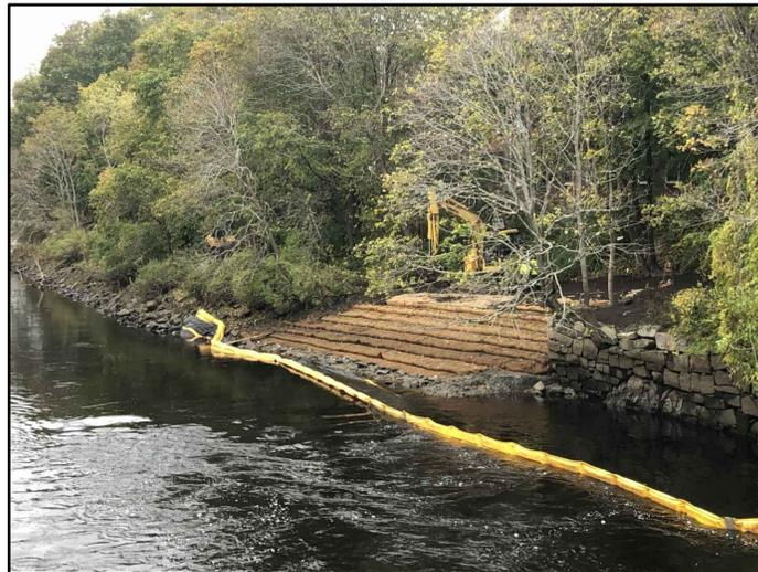
PHOTO - FABRIC ENCAPSULATED SOIL LIFT EXAMPLE
