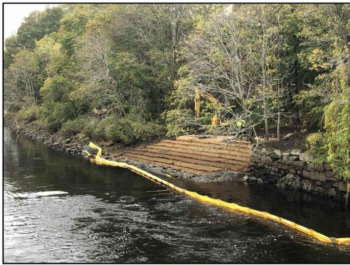
PHOTO - FABRIC ENCAPSULATED SOIL LIFT EXAMPLE
